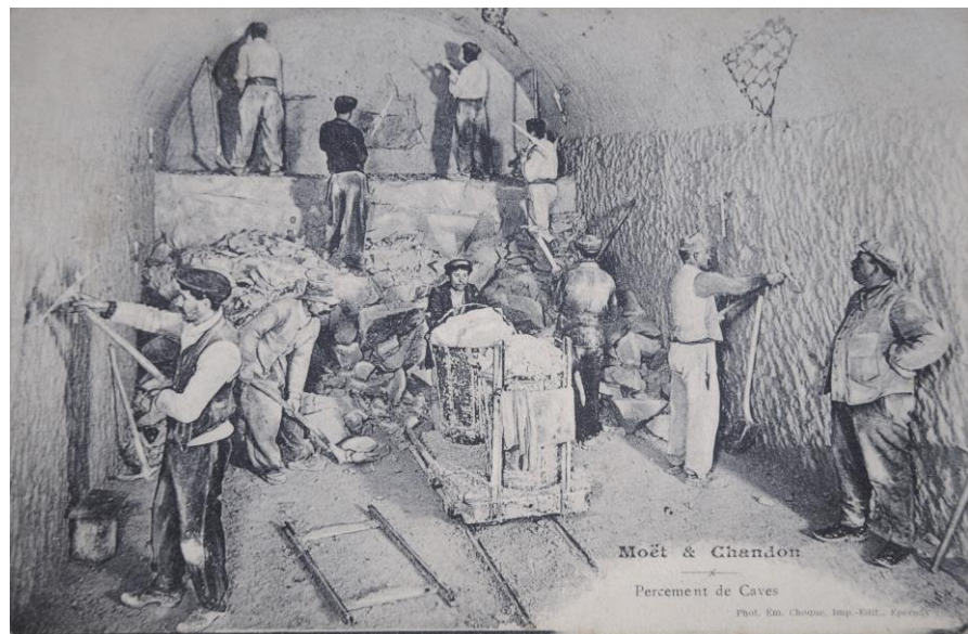
Creusement d'un Caveau dans la craie – Maison Moët & Chandon (coll. M. Thibault)
