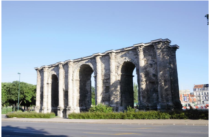
La porte Mars, proche du centre actuel de la ville de Reims © L'Auteur
