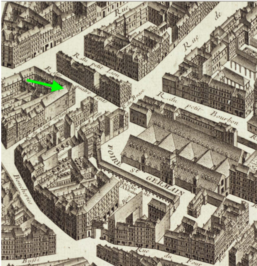
Figure 1 : Emplacement du jeu de paume d'Orléans, plan Turgot 1734. Michel-Etienne Turgot, Plan de Paris , 1734-1739, fac-sim., Paris, A. Taride, [début xx e siècle].
